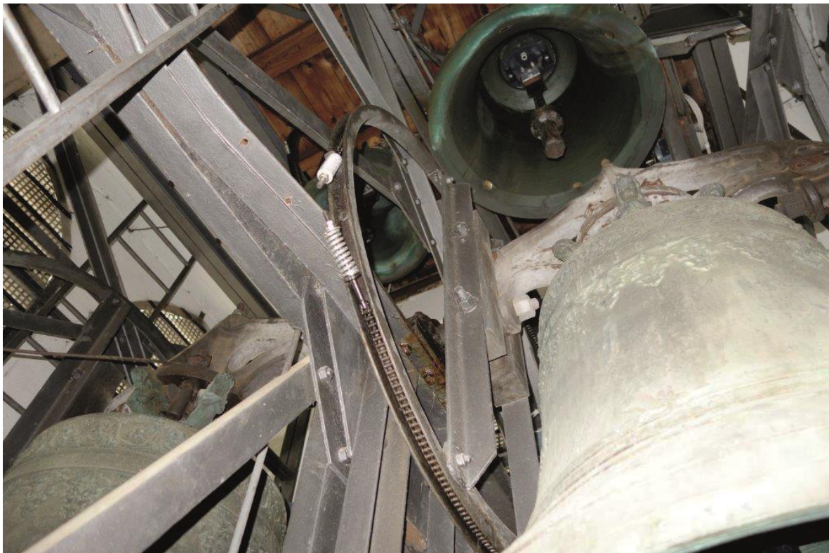
Ein Blick hoch zu unserem Sorgenkind, das plötzlich nicht mehr schlug.
